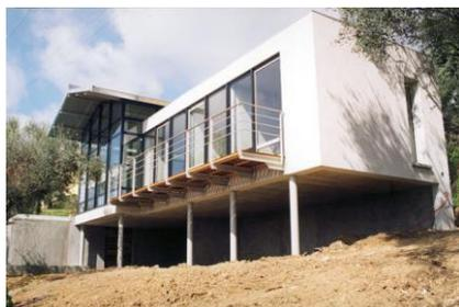
Ces tests sont indispensables pour connaître **la résistance des matériaux**, comme par exemple dans le cas d'une maison sur pilotis. Les poteaux se trouvant entre le sol et le plancher de la maison subiront **une compression**. Il faut donc être certain que les matériaux utilisés **résisteront** à cette contrainte.
